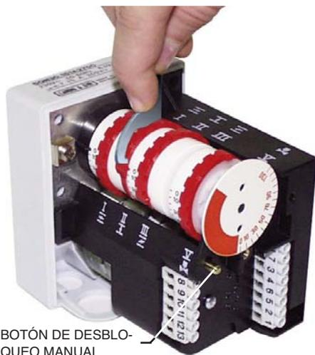
SERVOMOTOR DEL CIERRE DEL AIRE LANDIS & STAEFA SQN 30 151A2700
